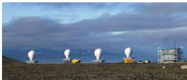
Obr. 3: Komunikační stanice ULS (Up-link Local Station) zajišťují pravidelné předávání obsahu navigačních zpráv na jednotlivé družice. Každá stanice je vybavena čtyřmi parabolickými anténami o průměru 3,5 m, může tedy současně komunikovat až se čtyřmi družicemi. Na obrázku je stanice umístěná na Špicberkách. Foto: ESA
