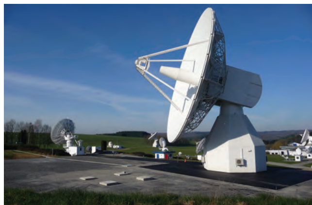
Obr. 4: Stanice TTCF (Telemetry, Tracking and Commanding Facility) slouží k telemetrickému sledování a řízení činnosti jednotlivých družic. Každá stanice je vybavena parabolickou anténou o průměru 11 m. Na obrázku je stanice situovaná ve středisku ESTRACK v Belgii. Foto: ESA
